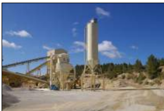
Dépoussiéreur et Silo à fillers
