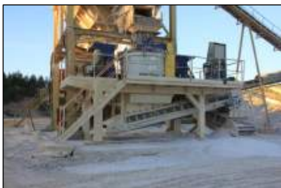
Concasseur à marteau (BM1) + Concasseur giratoire (MAG)
